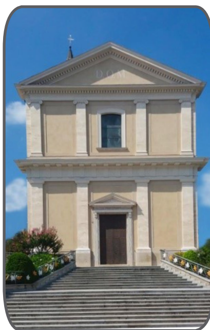
dopo i lavori
