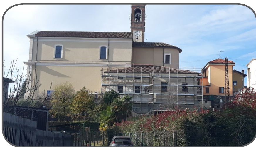
Impalcature sul blocco "sacrestia"
