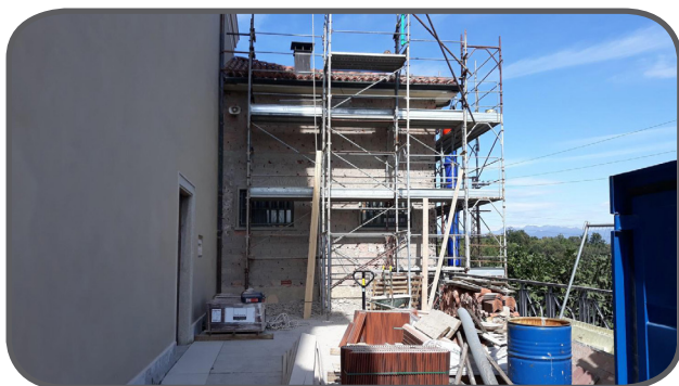
Facciata sacrestia (lato sud)
