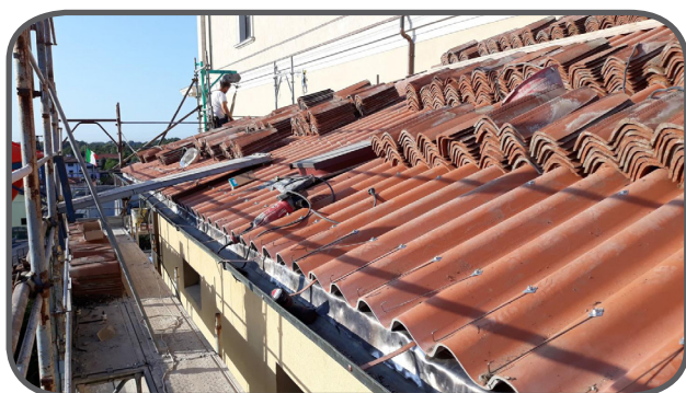
Tetto sacrestia (lato est)
