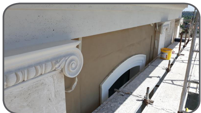
Pulitura, ricostituzione del modellato e consolidamento
